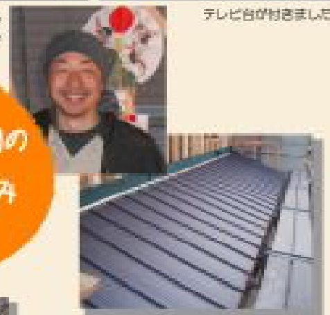
屋根を葺きました。
