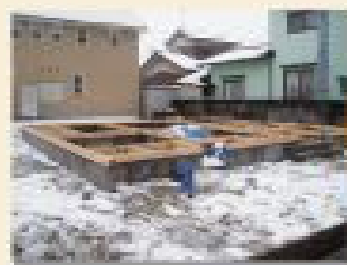
上棟に先立ち、土台を敷きました。もちろんヒノキ!
