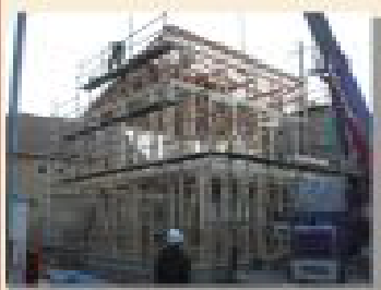
上棟当日、夕方までに外壁が完了しました。
