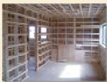
中は居住、工事が進行中です。
