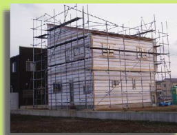
3/7(土) 外部下地工事
